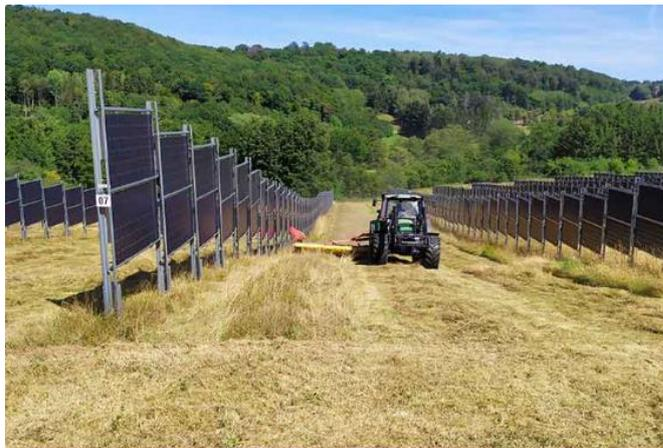
Abbildung 15: Vertikal ausgerichtete Agri-PV-Anlage (Quelle: Next2Sun)
