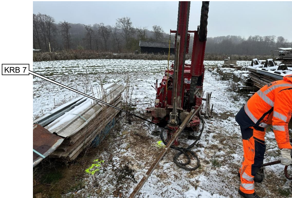
Foto 7: Blickrichtung ~ NO; Bereich der Bohrung KRB 7 (Markierung)
