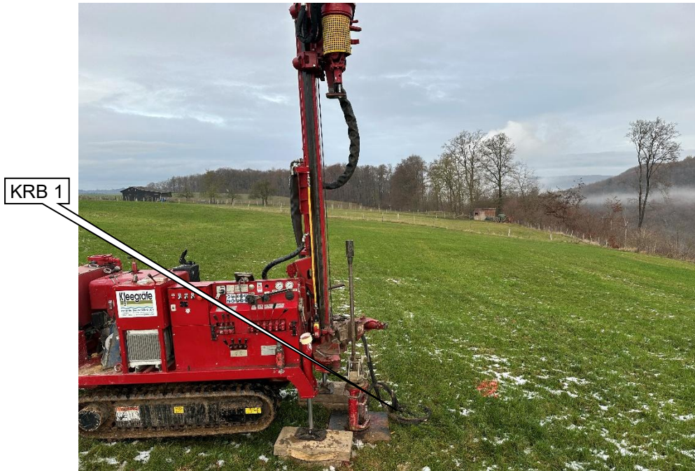
Foto 1: Blickrichtung ~ NW; Bereich der Bohrung KRB 1 (Markierung)
