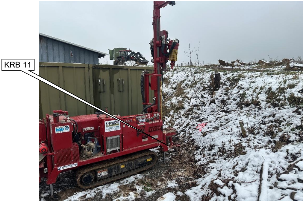
Foto 11: Blickrichtung ~ S; Bereich der Bohrung KRB 11 (Markierung)
