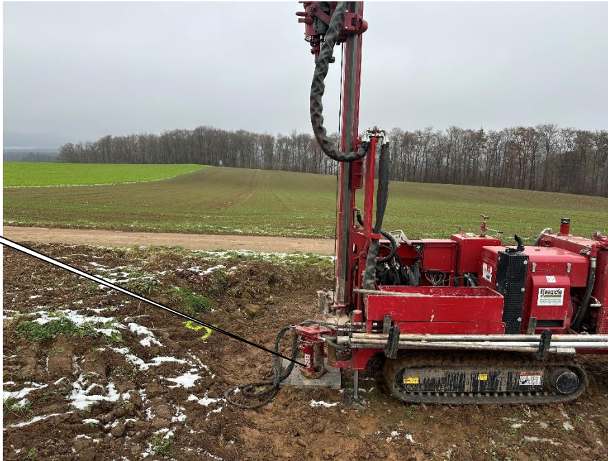
Foto 5: Blickrichtung ~ W; Bereich der Bohrung KRB 5 (Markierung)
