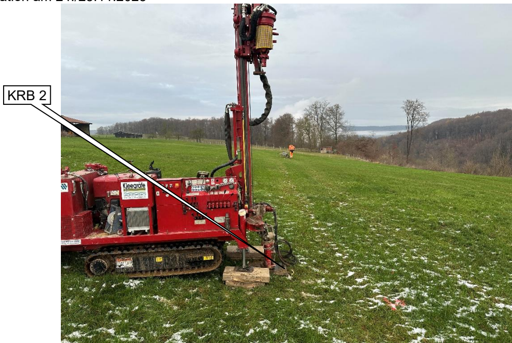
Foto 2: Blickrichtung ~ NW; Bereich der Bohrung KRB 2 (Markierung)
