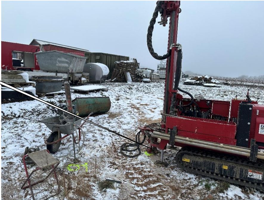
Foto 9: Blickrichtung ~ S; Bereich der Bohrung KRB 9 (Markierung)
