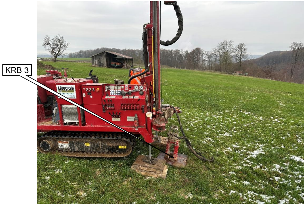
Foto 3: Blickrichtung ~ NW; Bereich der Bohrung KRB 3 (Markierung)
